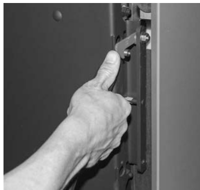
Fig. 5 Ouvrir le verrouillage de la porte du foyer
