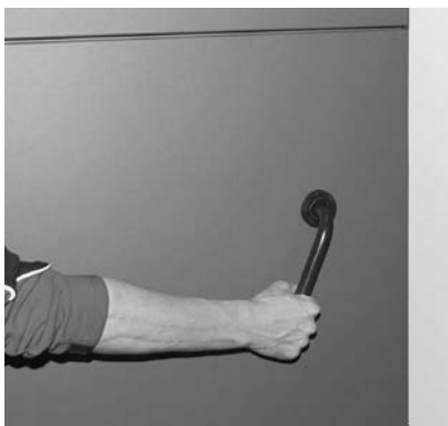
Fig. 25 Activer le levier de nettoyage des surfaces d'échange 5 à 10 fois
